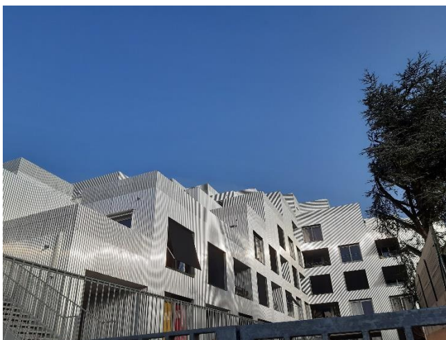
Eco-quartier Via Romana- architecte, S. Delhay - Dijon 2019©icovil
