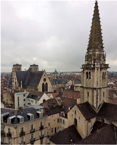
Dijon, site patrimonial remarquable
