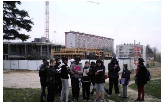
Chenôve- rénovation urbaine -chantier du Cèdre
