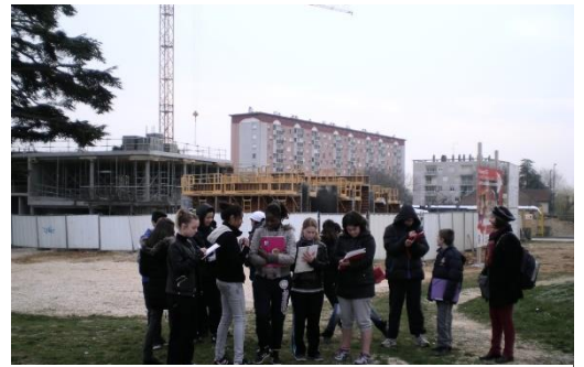
Chenôve- rénovation urbaine -chantier du Cèdre
