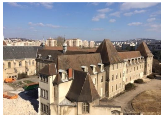
Future Cité de la gastronomie et du vin -travaux
